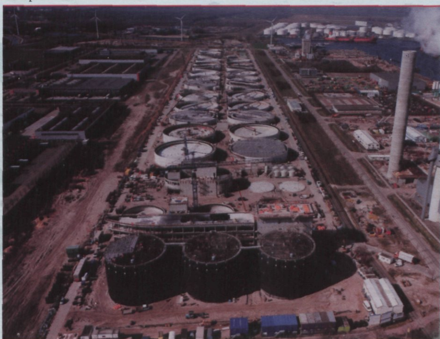
Luchtopname van het bouwterrein.
