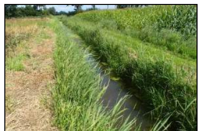
Figuur 8. De centrale waterloop (de Middenloop) is waterhoudend.
