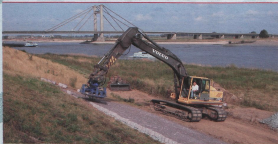
Dijkverbetering langs de Waal bij Beneden-Leeuwen (foto: Waterschap Rivierenland).
