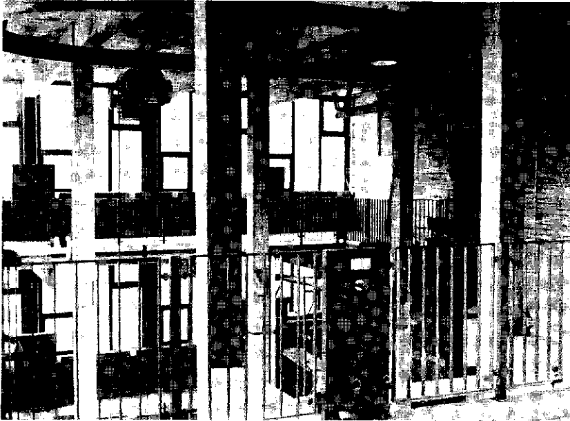
Afb.1 toont een deel van de werkhall in het toekomstige gebouw voor de Afdeling Verwerking. Hier zal o.a. technologisch onderzoek plaatsvinden.
