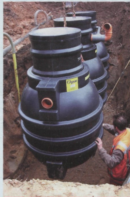
Plaatsing van IBA in Gelderland. Foto: Grontmij.
