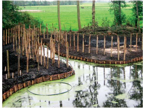
Bij het herstellen van eendekooien komen diverse specialisaties bij elkaar. Niet alleen het herstellen en aanleggen, maar ook het specialistisch handwerk om de wanden te vlechten.
