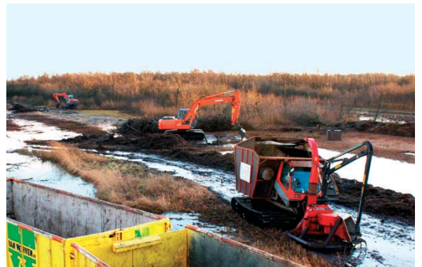
Voor de revitalisering van het trilveen in De Wieden is het hout tot 150 meter met een lier uit het gebied getrokken. Het zware hout is over water afgevoerd en het tophout ter plekke versnipperd.
