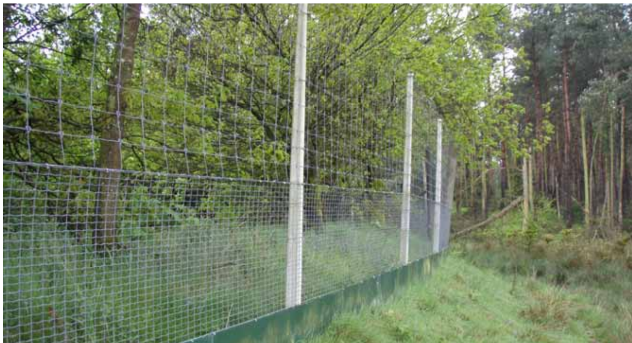
Fig 2.3 Om de veiligheid op de weg en het gebruik van ecoducten te optimaliseren zijn geleidende rasters geplaatst om dieren naar de ecoducten te geleiden. Vaak wordt combi-raster gebruikt om zowel grote als kleine dieren naar het ecoduct te sturen.
