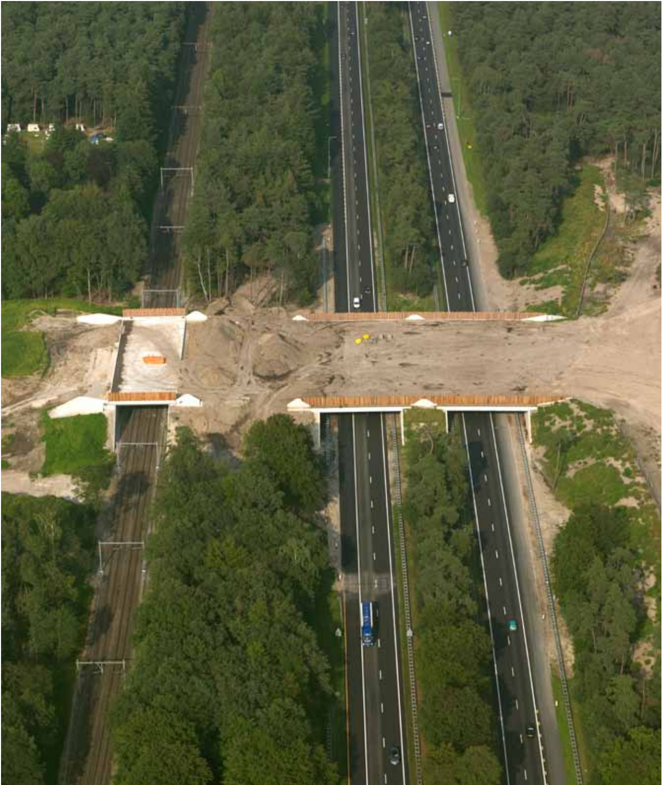
Bouw ecoduct Hulshorst over snelweg en spoorlijn
