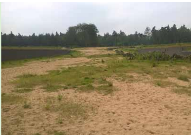
Fig. 4.21 De natuurlaag bovenop ecoduct Hulshorst is zandig en spaarzaam begroeid met grassen en heide.
