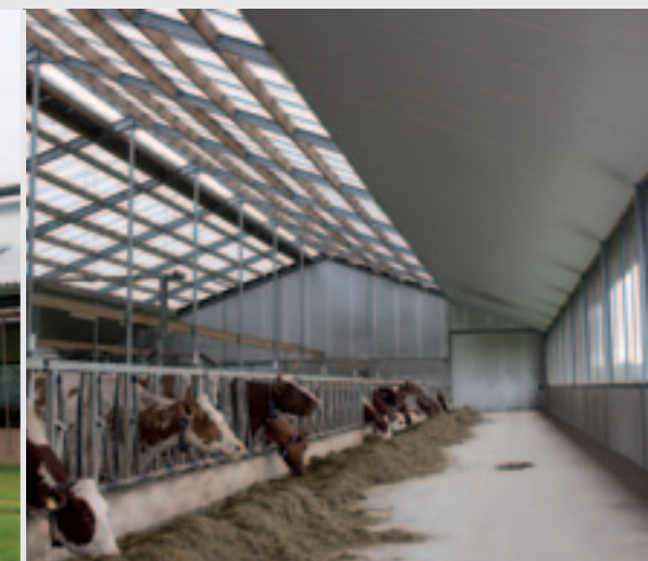
Boven het voer heeft Jan Vrugink isolatieplaten gemonteerd. Die gaan opwarming van het voer enigszins tegen.
