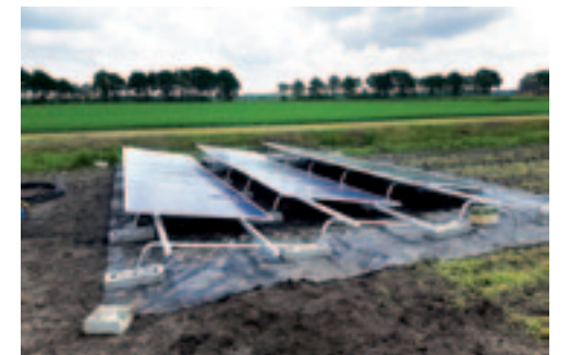
^ Zonnecollectoren voor de stroom Zonnecollectoren maken het gebruik van een generator overbodig.
