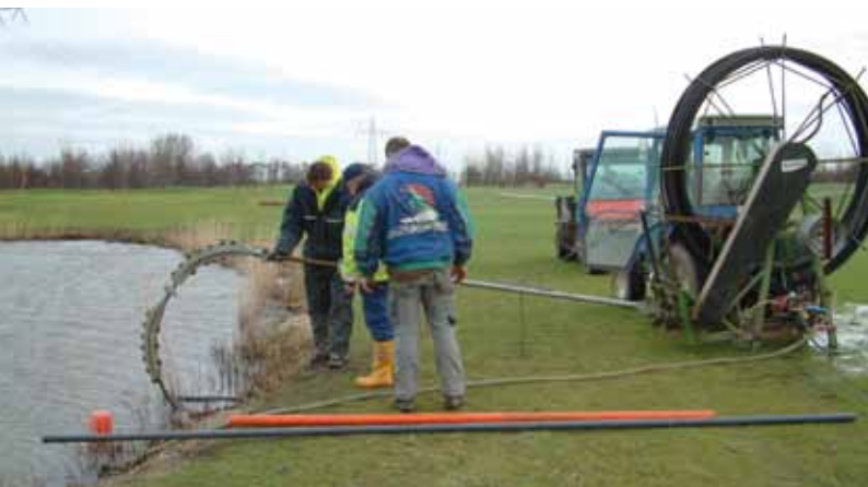
Doorspuiten van drainage.
