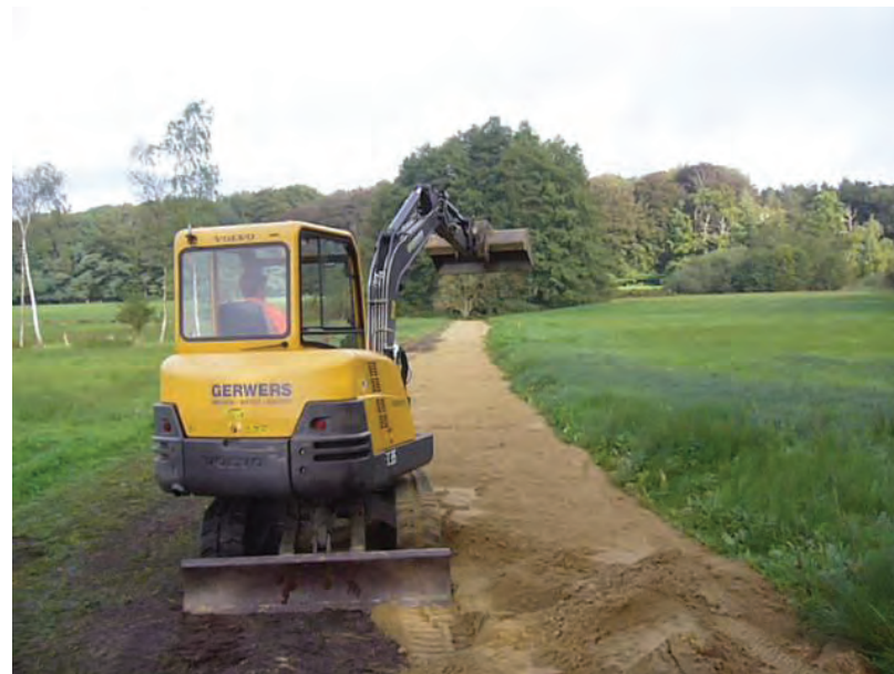
Figuur 11: Dempen van watergang in het dal van de Hazelbekke (Bron: Ecogroen)
