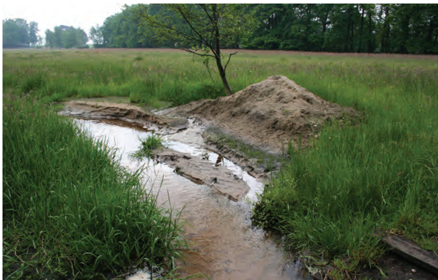
Figuur 12: Het aangevoerde zand wordt middels verspoeling in het te verondiepen beektraject van de Hazelbekke gebracht
