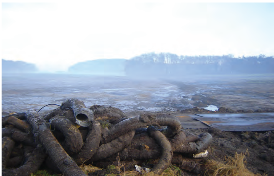
Figuur 14: Door het verwijderen van buisdrains herstellen de natuurlijke grondwaterstromingen en -standen
