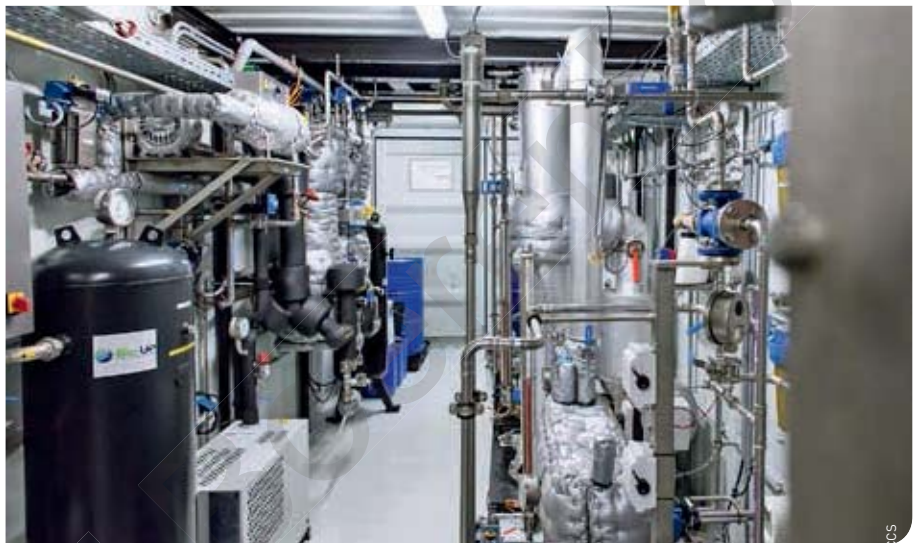
De Bio-Up verwijdert CO 2 , water en zwavelverbindingen uit het biogas. Vervolgens wordt een stof toegevoegd die de typische gasgeur geeft. Indien nodig voegt men stikstof toe om aan de aardgasnorm te voldoen.
