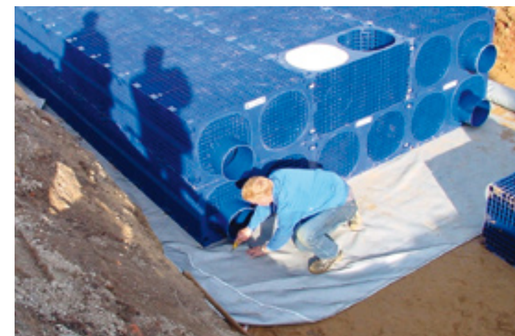
Wavin levert Q-bic kraten van 60 x 120 x 60 cm waarmee een holle ruimte voor wateropslag onder een sportveld wordt opgebouwd.
