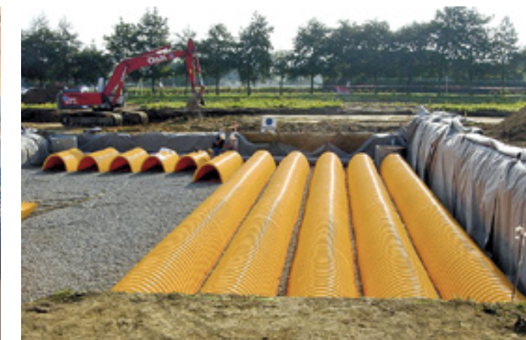
Nering Bögel werkt met halfronde kanalen van Ekofuture voor waterberging onder een sportveld.
