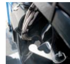
Vanaf het verdeelstuk loopt er één gasslang naar de motor en één langs het knikstuk naar de Air Variator.
