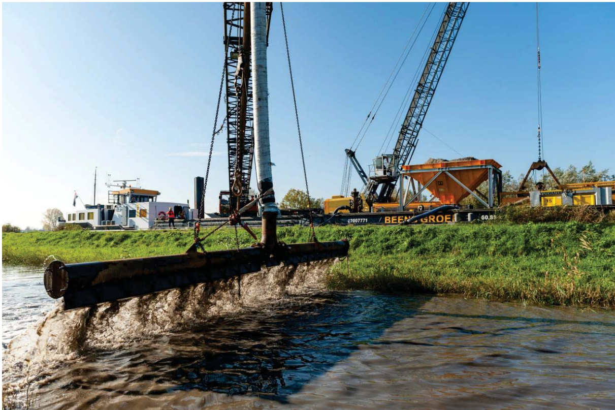
Afbeelding 2. Aanbrengen van een laagje zand
