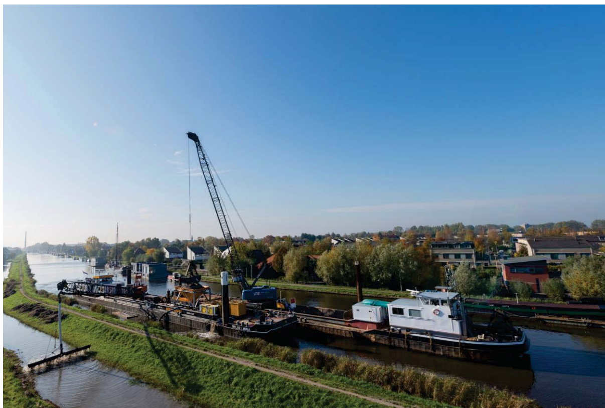
Afbeelding 1. Zandsproeien per schip
