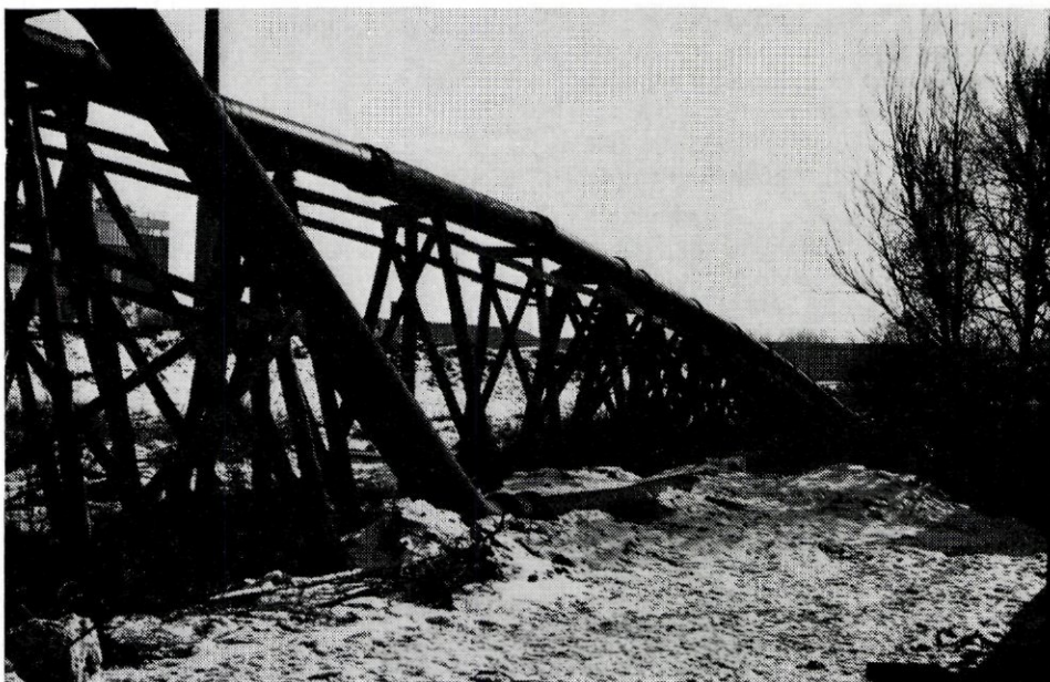
Pijpleiding voor het transport van havensediment naar stortplaats op land.
