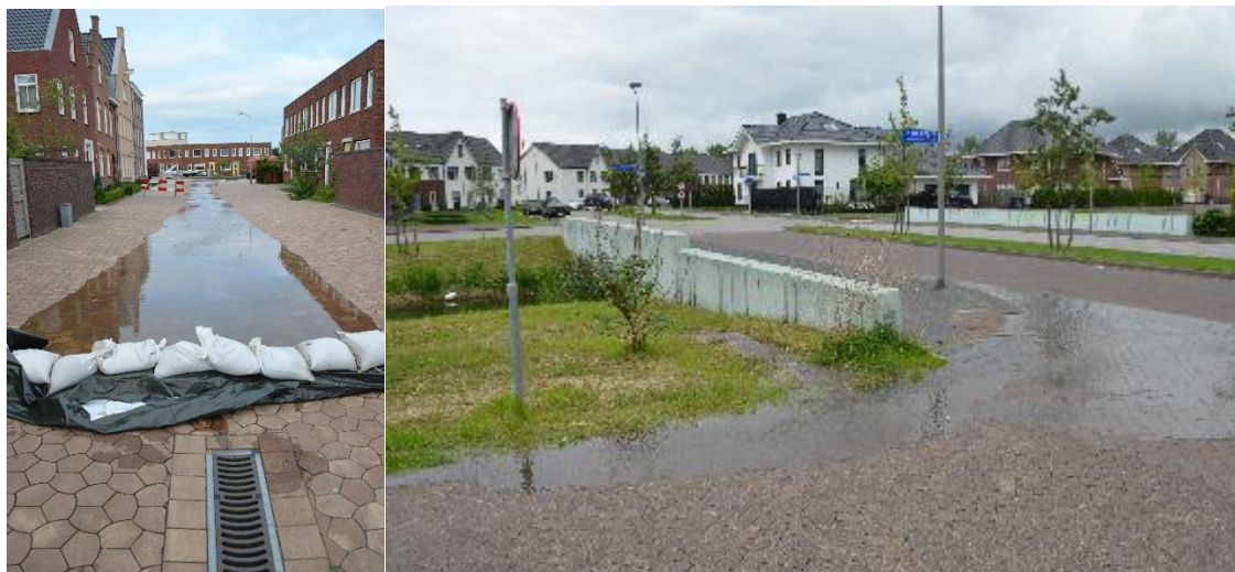
Afbeelding 2. Infiltrerend afvoerend plein (links), afvoer vanaf doorlatende verharding via goten naar oppervlaktewater bij gesimuleerde hevige bui (rechts).
