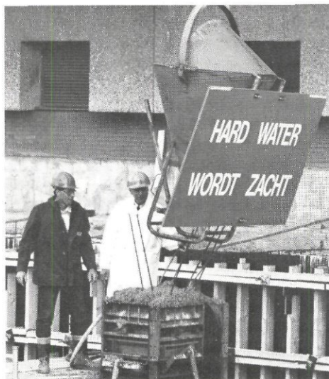
Ir. J. Haasnoot, technisch adjunct-directeur van het PWN (rechts), stort, geassisteerd door de heer H. J. Eiken Jr. (PWN), de eerste kubel beton voor de bouw van een onthardingsinstallatie bij pompstation Wim Mensink.
