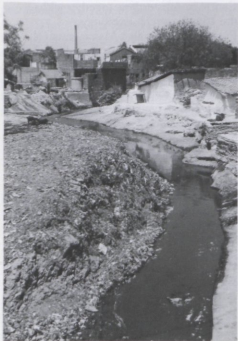
De Bengali ghat nala afvoer in Kanpur vóór en . . .
