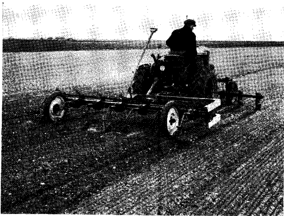
Afb. 2 Machinaal schoffelen en een bewerking in de rij met veertanden.
