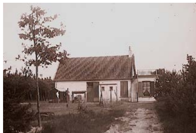
Afbeelding 6.9 Engelandersholt 22 vóór 1913. De trap en de hekwerk op het platte dak van de serre zijn intussen verdwenen (foto: Pieter Hamer)
