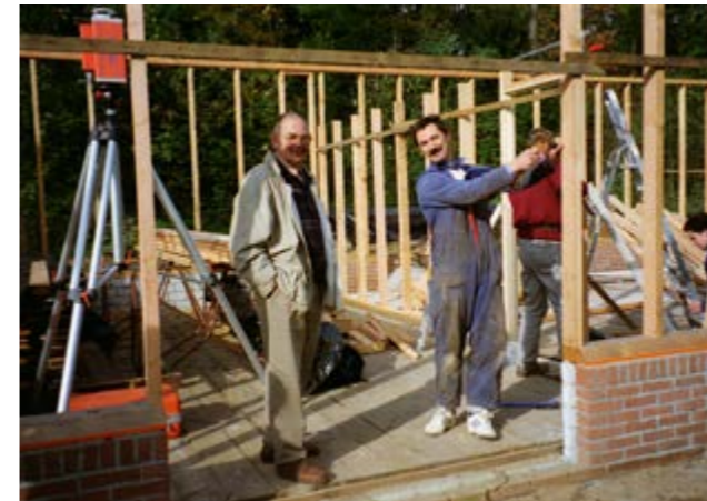
Afbeelding 6.26 Bouw (1995) en resultaat van de nieuwe schuur (foto: Marijke van Mansfeld)
