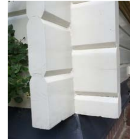
Afbeelding 7.5 Detail buitenwand Engelandersholt 20 (foto: Marijke van Mansfeld)
