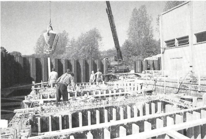
Afb. 3 - Bouw inlaatwerk Oranjekom.
