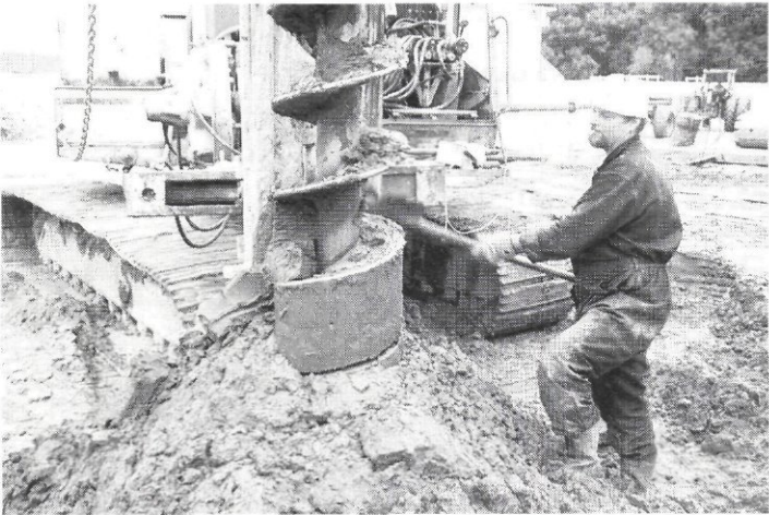
Afb. 9 - Grondboorinstallatie.
