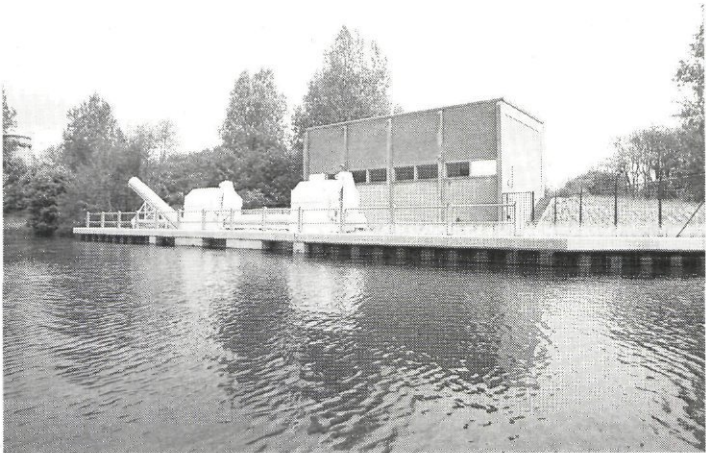
Afb. 4 - Het vernieuwde inlaatstation.
