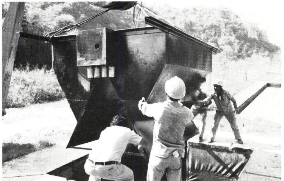
Afb. 4 - Inhijsen gasafscheider/invoerwerk.
