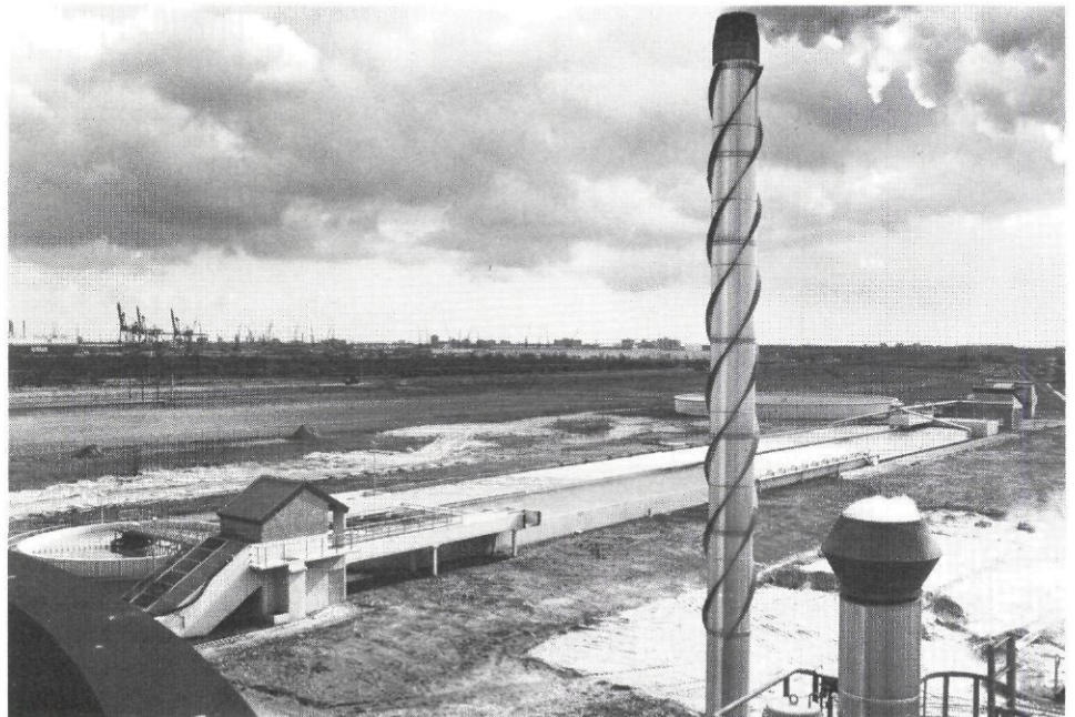
Afb. 4 - Aëratietank met aan de voorzijde (rechts op de foto) het ontvangwerk en de opslagtank voor toxische lozingen en aan de achterzijde (links op de foto) de slibindikker en retourslibvijzel.
