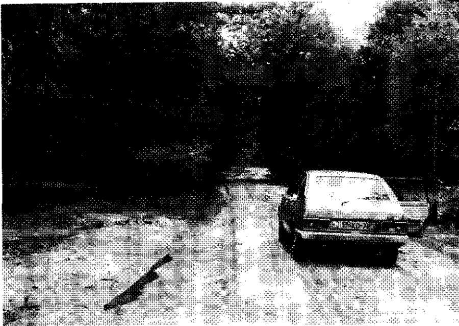
Foto 4.9 Tonrond aangelegde en onderhouden zandbaan met frequent verkeer. Er is hier niet of nauwelijks wateroverlast.
