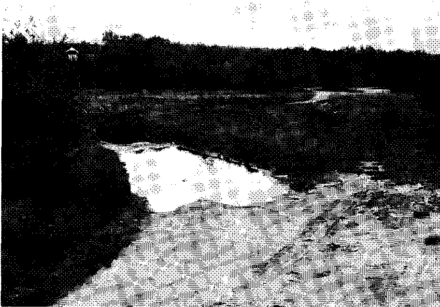
Foto 4.2 Regenwater zakt minder snel weg op verdichte bodems van cultuurtechnisch niet op de moderne manier bewerkte en onderhouden wegen. Verbreding van wegen is een van de effecten.
