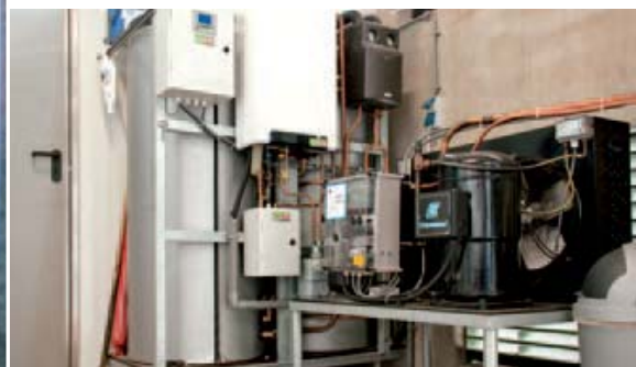
v De Agriheat-boerderijboiler is een compleet systeem voor de warmwatervoorziening in de stal en te koppelen met verwarming voor kantoor.
