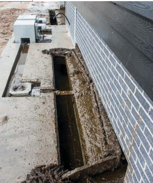
Links: de mest en het zand belanden achter de stal in een goot die wordt doorgespoeld met dunne fractie om mest en zand te scheiden Rechts: de koeien worden gemolken in een 2x12 zij-aan-zijstal met snelwisselsysteem
