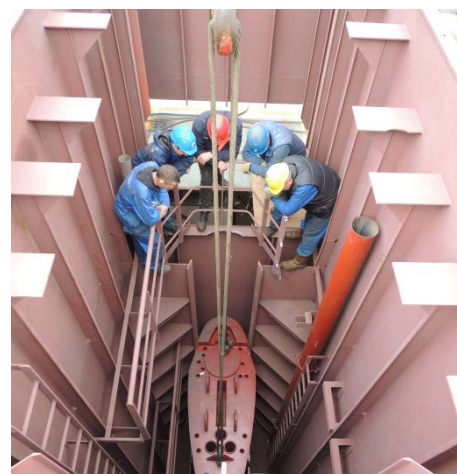
De installatie van de dropkiel in de Tridens
