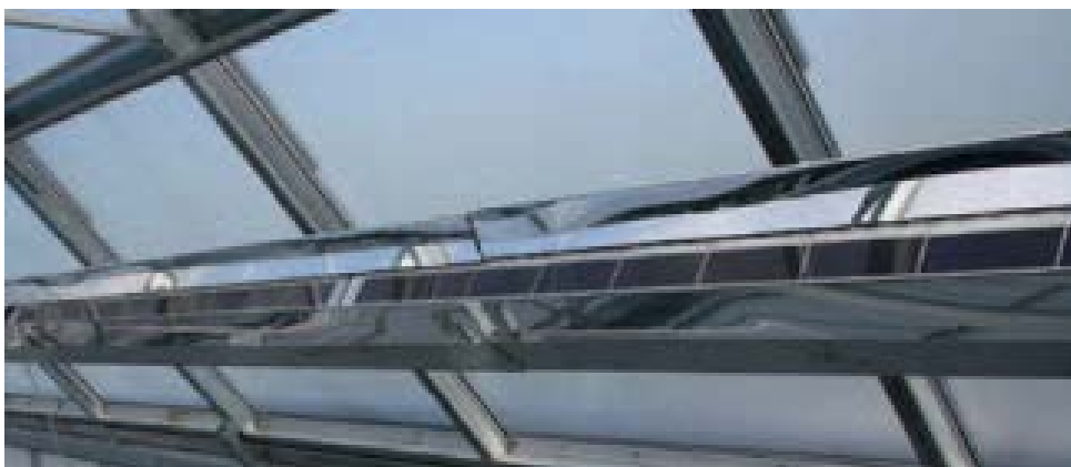
Foto 19: Een prototype voor een CPV-module in de DaglichtKas. (bron: de Zwart et al. 2011)
