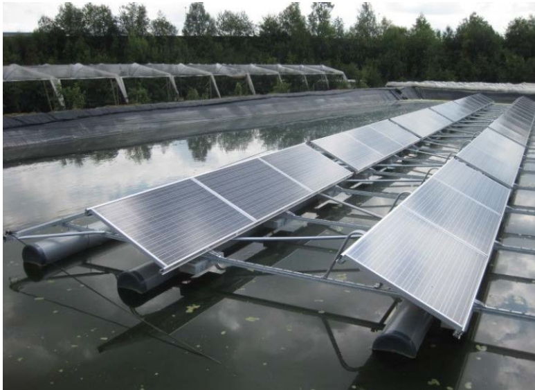
Foto 5: Voorbeeld van drijvende zonnepanelen op een regenwaterbassin te Veghel (bron: Mol, 2015)
