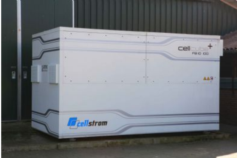
Foto 21: Vanadium Redox Flow Batterij voor opslag van zonnestroom bij melkveebedrijf (bron: www.fotonenboer.nl )
