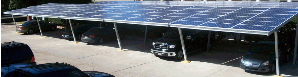
Foto 15: Er zijn carports die zowel als zonnestroom-oplaadpunt voor elektrische machines en auto's dienen als voor teruglevering aan het net.
