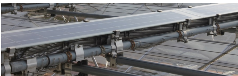
Foto 3 en Foto 4: 20 cm brede PV panelen op afdekkapjes van een buitenscherm op een orchideeënkas (bron: www.orchidee.nl )
