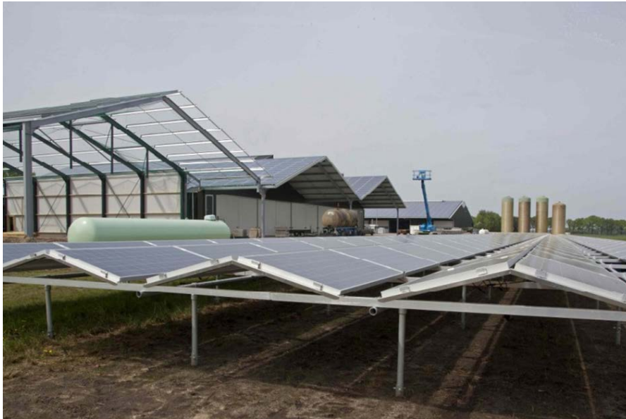
Foto 20: Oost west opstelling (bron: www.zonneparkennederland.nl )
