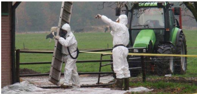
Foto 7 en Foto 8: Asbestverwijdering (bron: www.asbestvanhetdak.nl )
