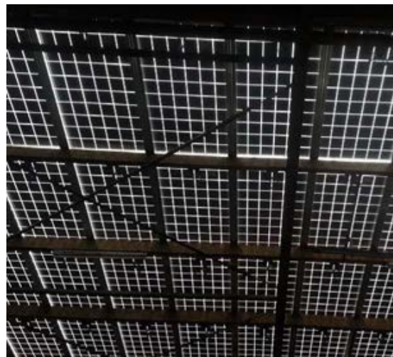
Foto 14: Licht doorlatende zonnepanelen als dak
