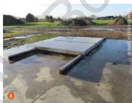
1 De verwarmingsketel heeft een vermogen van 250 kW. 2 De uitgebrande as komt terecht in een asemmer die af en toe moet worden leeggemaakt. 3 De ondergrondse opslagbunker voor de houtsnippervoorraad. De snippers worden van hieruit met een vijzel naar de ketel getransporteerd. 4 Bij elk afnamepunt wordt warmte via een warmtewisselaar uit het netwerk gehaald.
