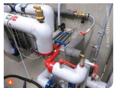
1 De verwarmingsketel heeft een vermogen van 250 kW. 2 De uitgebrande as komt terecht in een asemmer die af en toe moet worden leeggemaakt. 3 De ondergrondse opslagbunker voor de houtsnippervoorraad. De snippers worden van hieruit met een vijzel naar de ketel getransporteerd. 4 Bij elk afnamepunt wordt warmte via een warmtewisselaar uit het netwerk gehaald.
