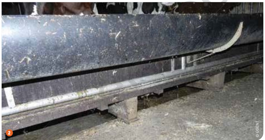
Een rubberen beschermingsplaat biedt vleeskalveren bescherming tegen tocht die van onderuit in het groepshok komt. 1 Een hok zonder beschermingsplaat 2 Een hok met bescherming.
