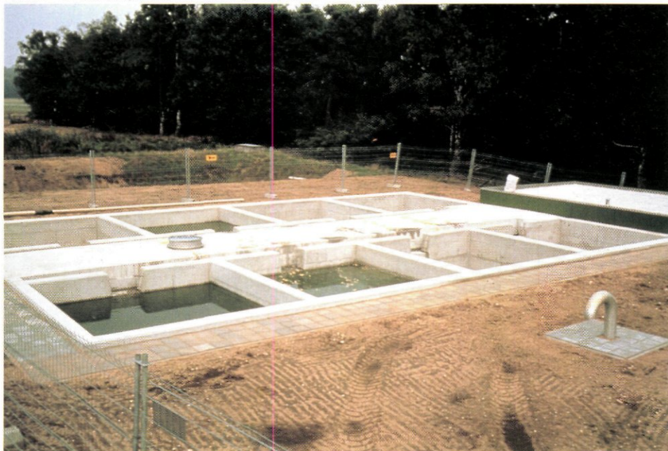
Afb. 10 - De acht compartimenten van de praktijkinstallatie Montferland
