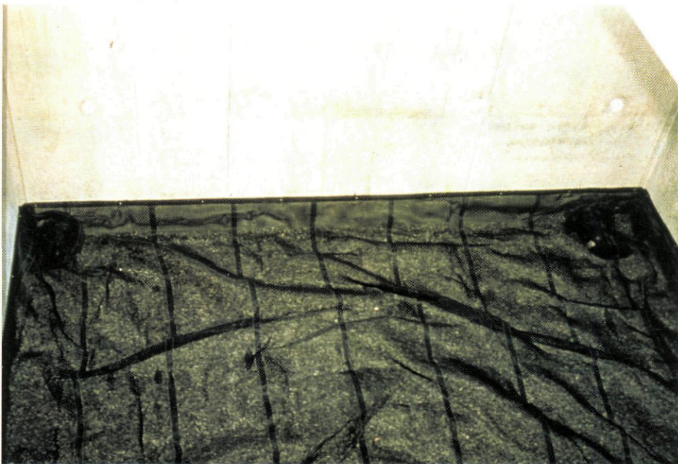
Afb. 12 - De waterdoorlatende polyetheenmat als scheiding tussen de grindsteunlaag en de kalksteensteunlaag in compartiment 1 van de praktijkinstallatie.
