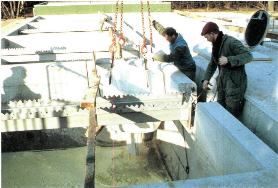
Afb. 14 - Vullen van de compartimenten met het zwavel/kalksteenmengsel.
