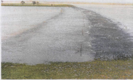
Fig. 2. Overlaat van een groene rivier (geen noodoverloopgebied!). Groene rivieren worden ingezet als het water tussen de bandjiken van de rivier niet meer verwerkt kan worden. [Bron: Silva et al., 2000. Ruimte voor de Rijntakken: wat het onderzoek ons heeft geleerd . RIZA-nota 2000.26, ISBN 9036953235].
