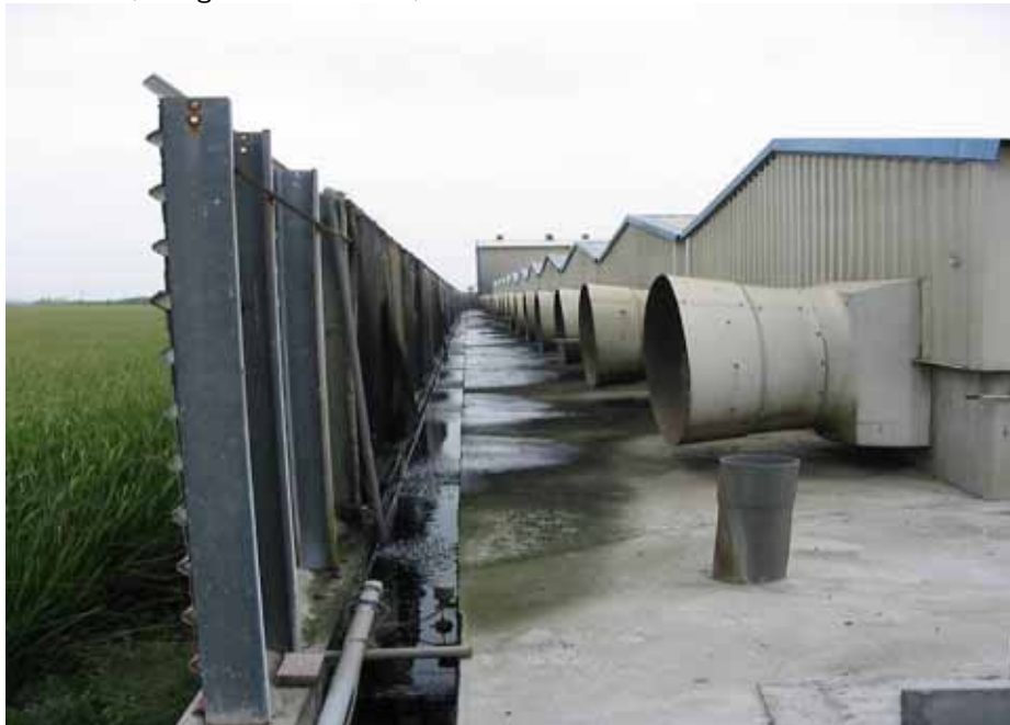
Figuur 1 Toepassing van verticale watergordijnen voor het afvangen van stof uit ventilatielucht (Foto gemaakt in Taiwan)
