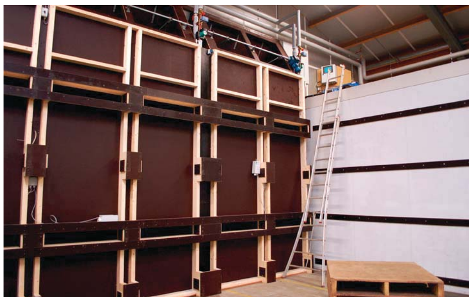
Droogwandgoten (bij Boltha BV) gekoppeld aan de Bulbstoremanager (archieffoto)
