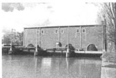
Ex- en interieur van het gemaal Zeeburg
