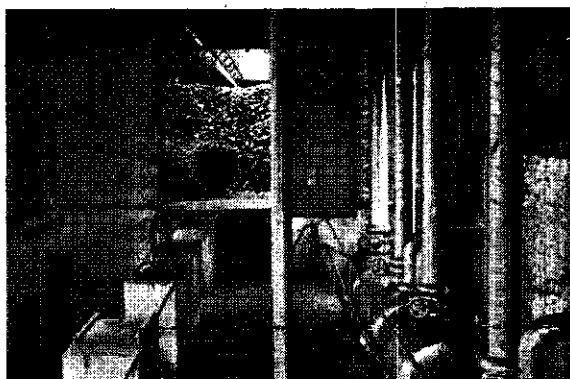
Fig. 6. Ketelhuis met reeks lagedruk-stoomketels en steenkooltoevoer (Deense bruinkool) met onderlosser aan loopkat
