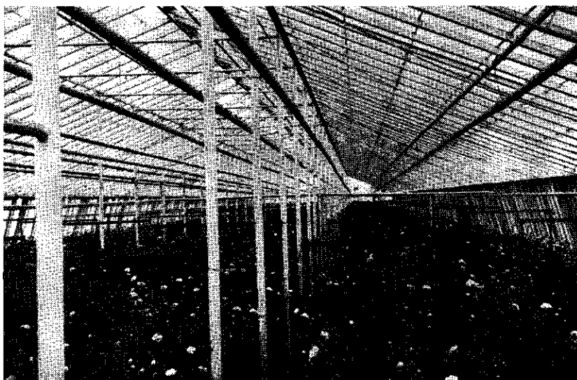
Fig. 4. Anjerkas met stijlen en schuinstaande zijwand
