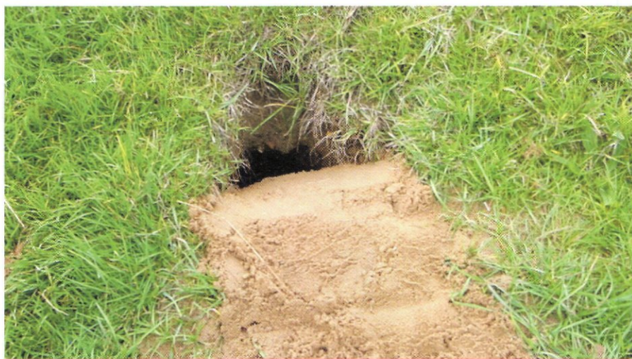
Holen in de dijk die door het waterschap voor driekwart dichtgegooid zijn.
