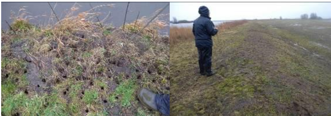
Figuur 4.5. Muizen in waterkeringen. Beginnende bresvorming bij het buitentalud van de opvaart in Pikesyl (links) en vrijwel kaalgevreten kering (rechts) aan de oevers van It Fliet.
