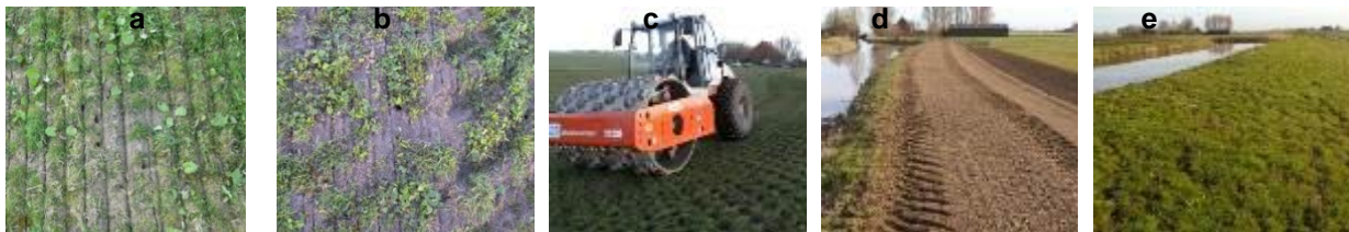
Figuur 7.4 Beelden van de herstelmaatregelen zoals die rond 15 april 2015 zijn uitgevoerd op de proeflocatie in Pikesyl (a-e).
