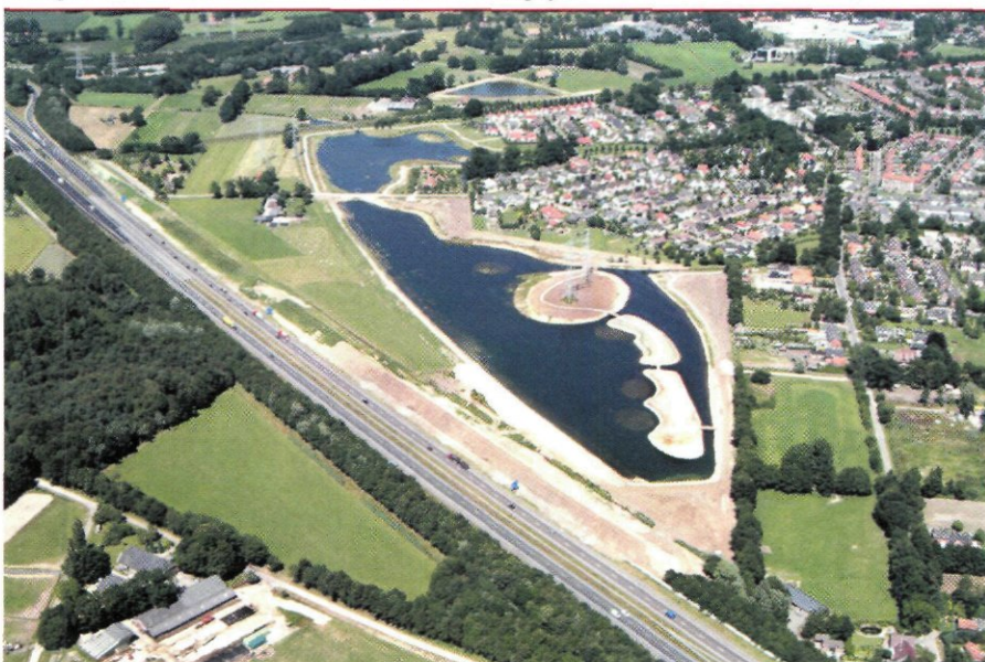
Waterpark 't Genseler, onderdeel van het Woolderbinnenbeekproject.
