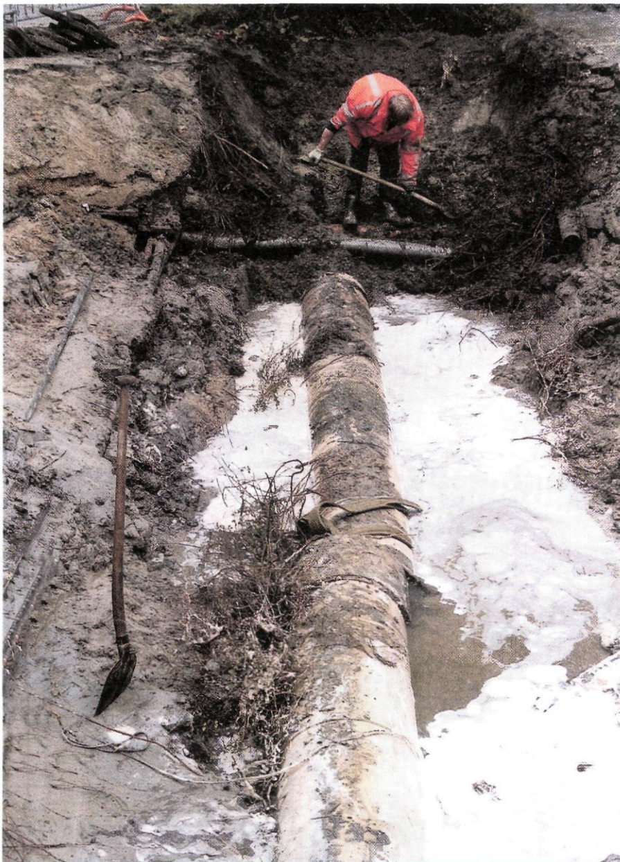
Overlast na een breuk in een \varnothing 500 mm PVC-leiding.
