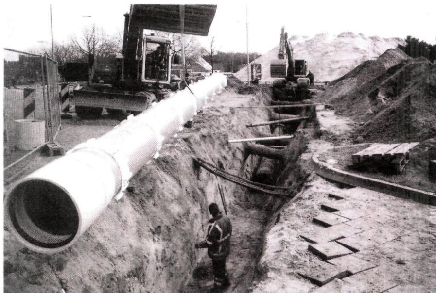
Aanleg van een PVC-leiding voor de distributie van drinkwater.
