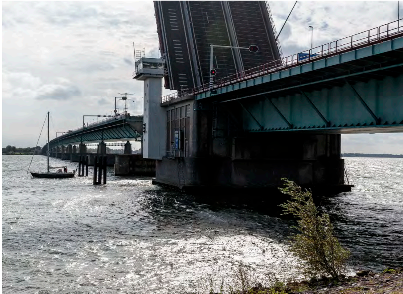
Hellegastplein, Haringvliet Bridge
