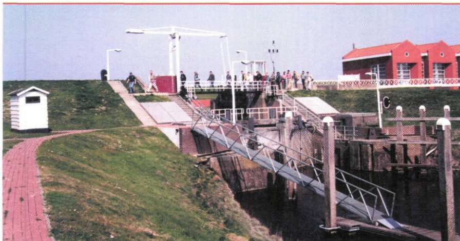
Het sluizencomplex in Termunterzijl, met op de achtergrond gemaal Rozema.
