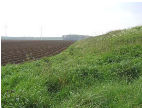
2.3a. Hoge dijk met ruige vegetatie, langs bedrijf Dekker
