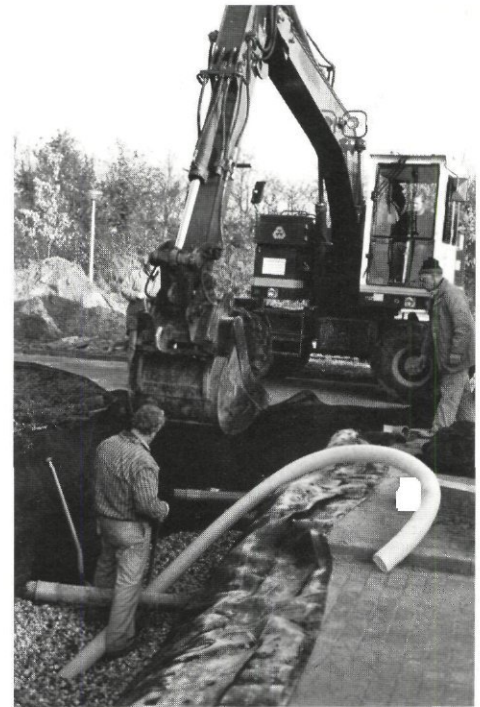
De aanleg van de infiltratievoorziening voor de proefopstelling in de wijk Geren te Zwolle.
