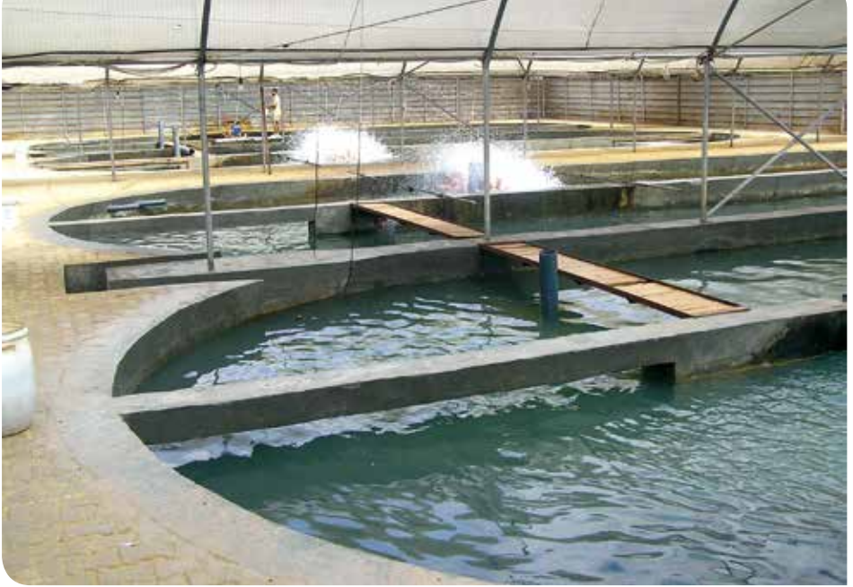
Foto 4. De bassins worden met peddelwielen belucht.
