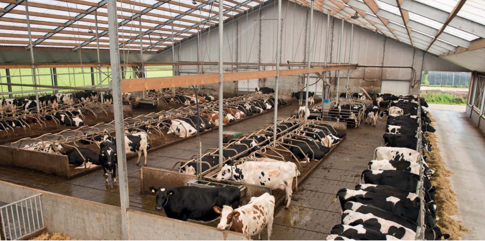
Het volledig lichtdoorlatende staldak zorgt ervoor dat het qua hoeveelheid licht lijkt alsof je buiten staat
