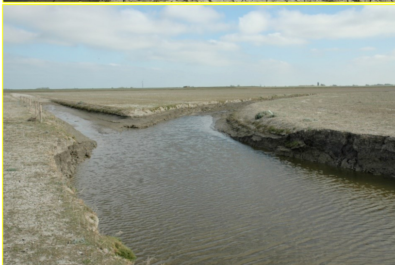
Foto 1 – 3 De doorgraafopeningen van west naar oost met de gegraven kreek en aangelegde kunstwerken, vanaf de kwelder de Proefverkweldering inkijkend. Foto 1 (boven) toont kreek met voetgangersbrug in het westen in mei 2012. Foto 2 toont kreek met duiker in de middelste doorgraving (mei 2007). Foto 3 toont de oostelijke doorgraving zonder kunstwerken met de splitsing van de gegraven kreek vlak achter de doorgraafopening (mei 2007).
