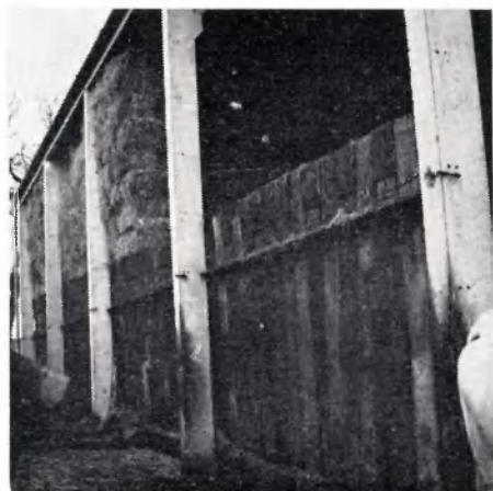
20. In het beton van de spanten zijn op regelmatige afstanden boutgaten aangebracht
