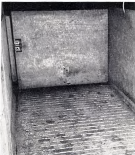
23. Roostervloer in de mestgang
