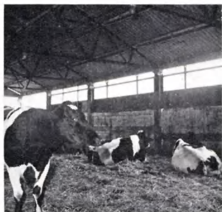
18. Een loopstal met stalen spanten
