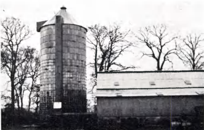
13a. De torensilo met de daarbij opgestelde voedervijzel
