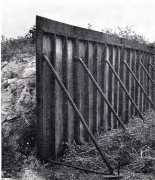
21. Een sleufsilo met verplaatsbare wanden
