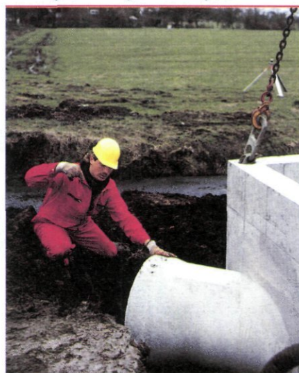
De aanleg van riolering in het buitengebied.
